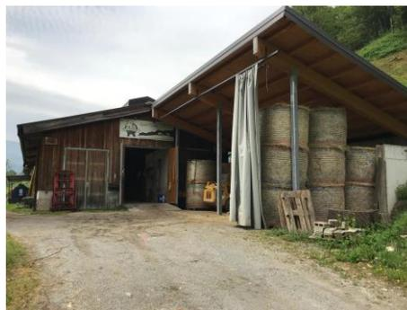
Fig. 1. Esempio di stalla con struttura in muratura e carpenteria in legno per 80 capre in lattazione (foto N. Marchetti)
