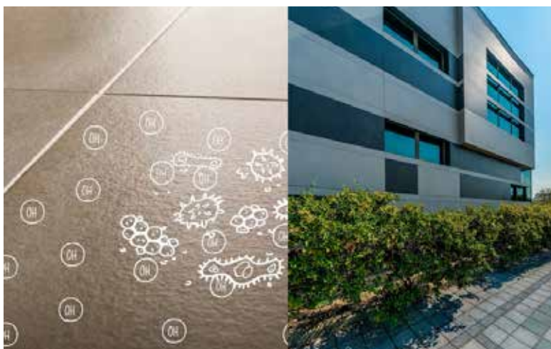
CERAMICHE ACTIVE SURFACES IMPIEGATE COME ELEMENTI ARCHITETTONICI CON PROPRIETÀ AUTOPULENTI E AUTOSTERILIZZANTI.
